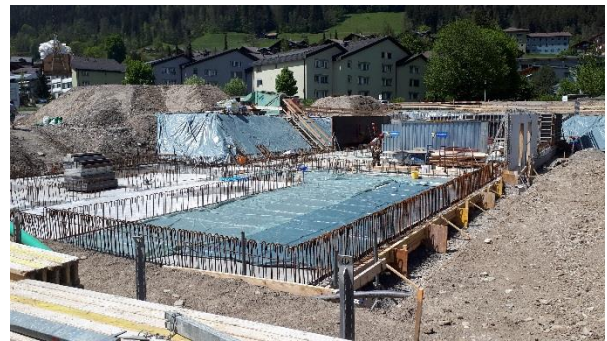
Fundamentarbeiten des Untergeschosses
